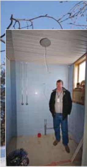
As Oy Soukanvuori, Espoo. 1960-luvun lähiörakennuskohde. Vastaava työnjohtaja Jari Keskitalo.
